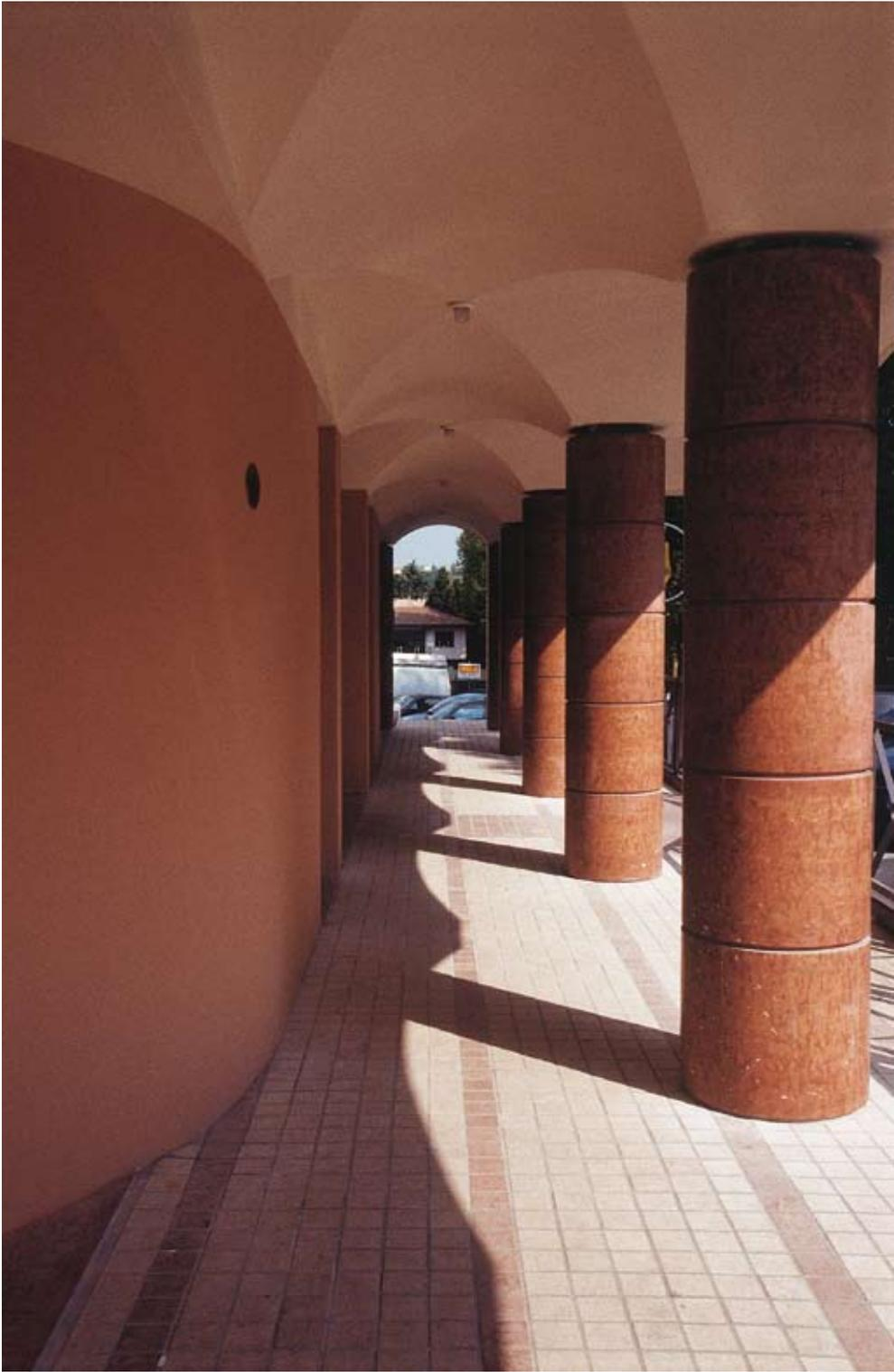
La struttura in elevazione si compone di telai in conglomerato cementizio armato, disposti, in senso longitudinale e trasversale, secondo le linee di massima sollecitazione, in modo da non lasciare zone prive di elementi di irrigidimento.
